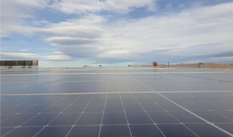
**DESCRIPCIÓN:** ADQUISIÓN E INSTALACIÓN DE PLACAS SOLARES EN LA COFRADÍA DE ÁGUILAS. Instalación de placas solares en la LONJA de ÁGUILAS. Se han instalado 220 Unidades, con una potencia de 540W cada una.
