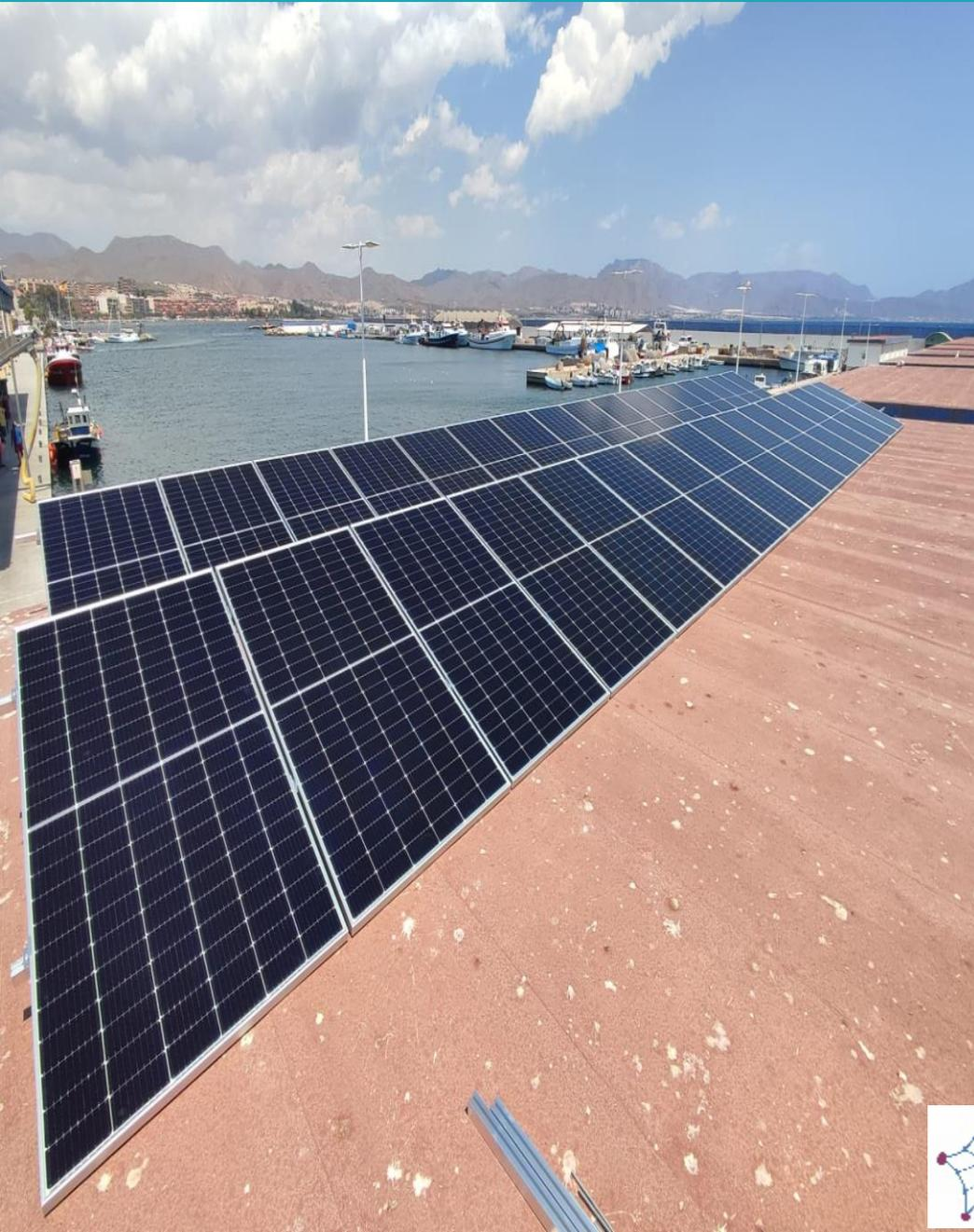
**DESCRIPCIÓN:** ADQUISICIÓN E INSTALACIÓN DE PLACAS SOLARES EN LA COFRADÍA DE PESCADORES DE MAZARRÓN. Instalación de placas solares con el fin de conseguir la total autonomía energética mediante la autoproducción de energías 100% renovables. Se han instalado 186 Unidades, con una potencia de 540W cada una.
