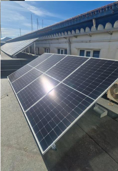
**DESCRIPCIÓN:** ADQUISICIÓN E INSTALACIÓN DE PLACAS SOLARES EN LA COFRADIA DE CARTAGENA. Instalación de placas solares con el fin de conseguir la total autonomía energética mediante la autoproducción de energías 100% renovables. Se han instalado 87 Unidades, con una potencia de 550Wp cada una.
