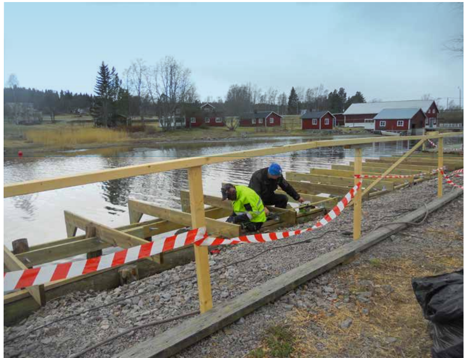
▲ Construcción de un nuevo pontón en Tynderö.
