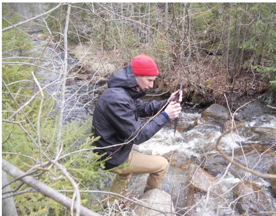
▲ Erik Spade inspeccionando un conducto bajo la carretera de un bosque.
